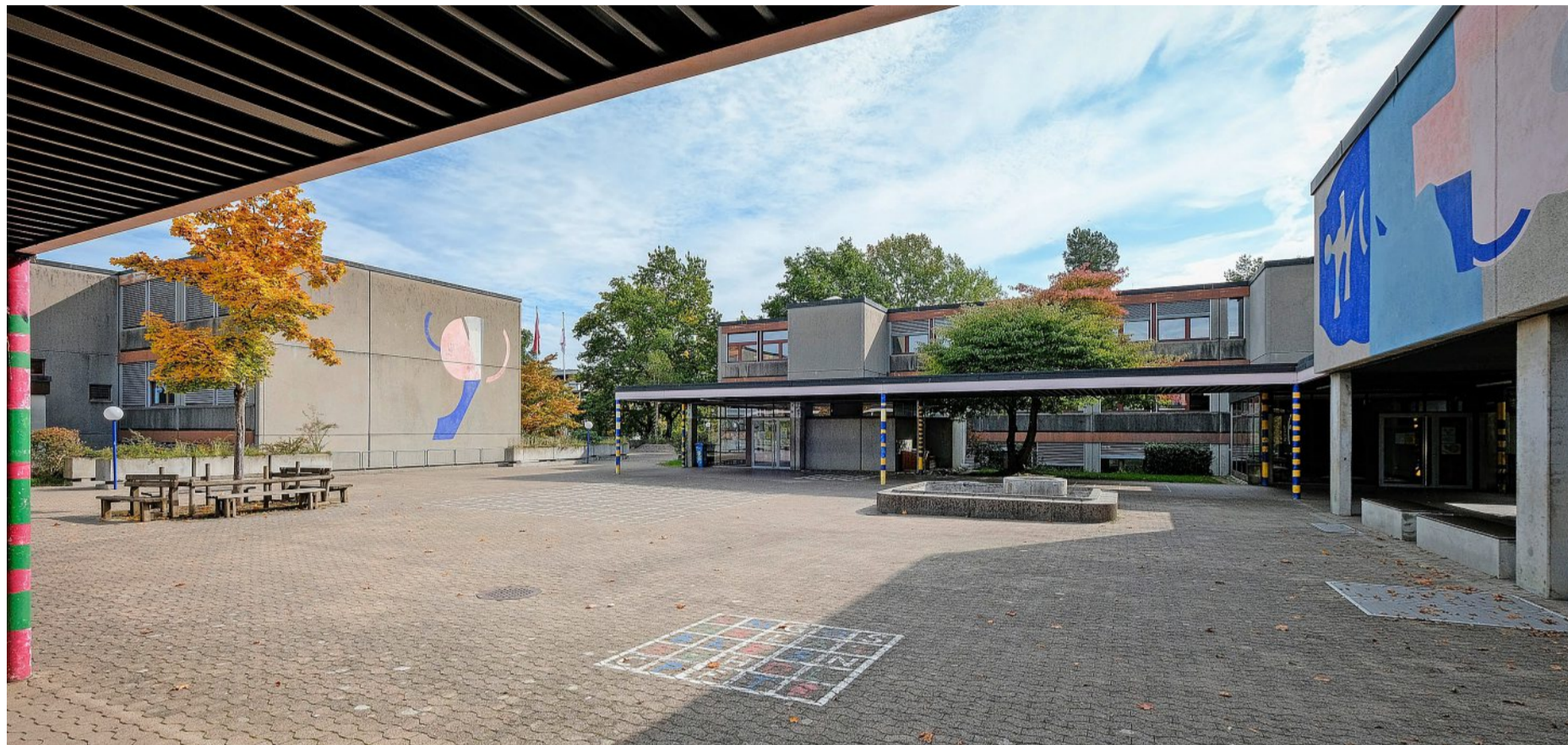
Muss nach über 40 Jahren umfassend saniert und erweitert werden: Das Primarschulhaus Steinacker in Seen. Foto: Enzo Lopardo
